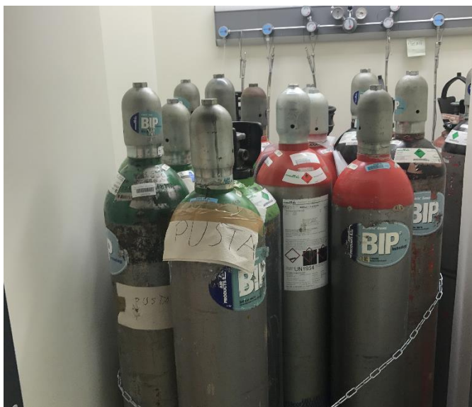
Przykładowe widoki magazynowania butli z gazami palnymi i wybuchowymi, które mogą tworzyć mieszaninę wybuchową.
