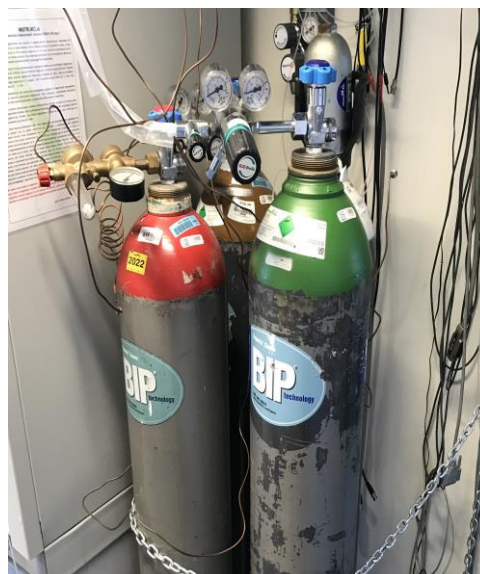
Przykładowe widoki magazynowania butli z gazami palnymi i wybuchowymi, które mogą tworzyć mieszaninę wybuchową.
